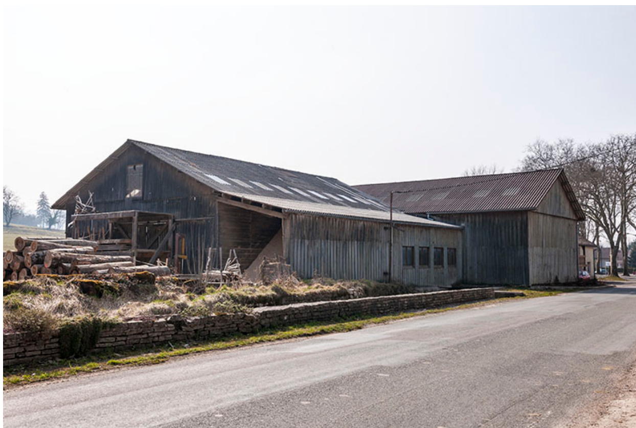
Atelier de sciage depuis le nord-est.
