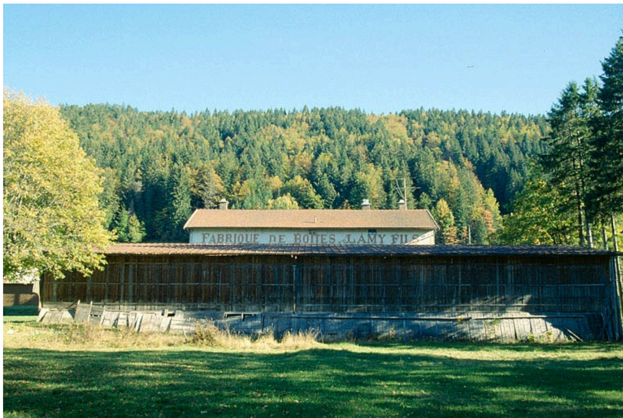
Façade postérieure du séchoir.
