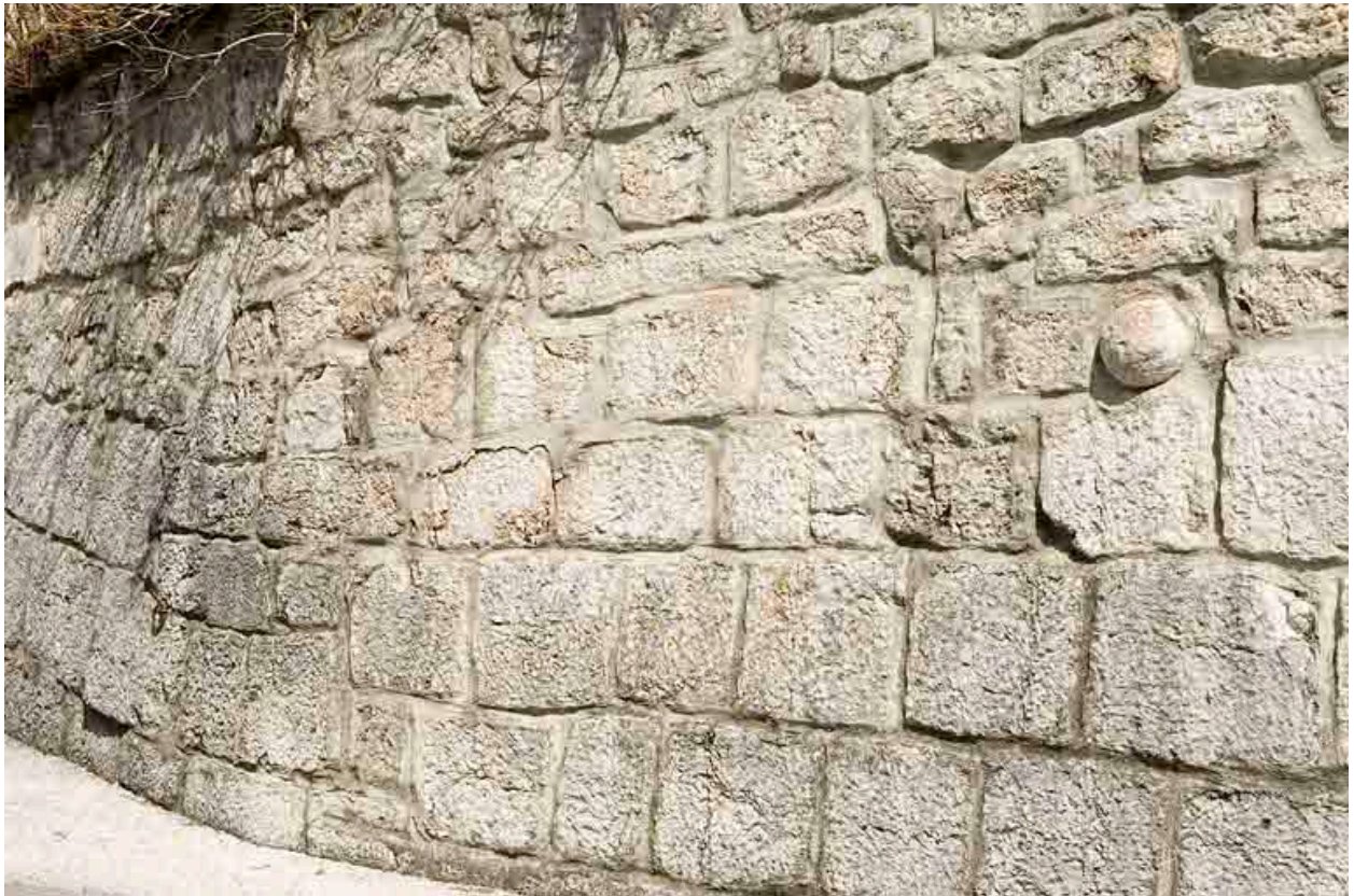
Enceinte : détail du bossage.
