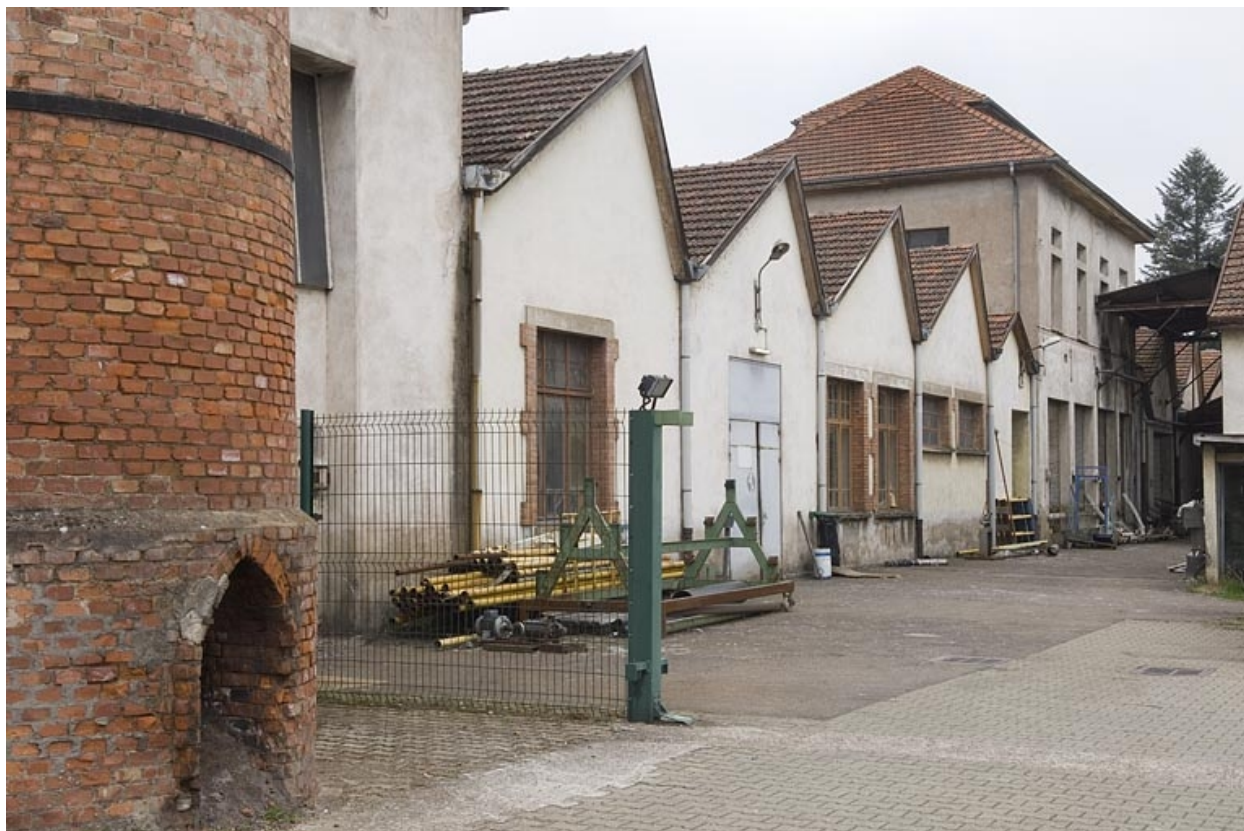
Pignons des sheds de l'atelier.
