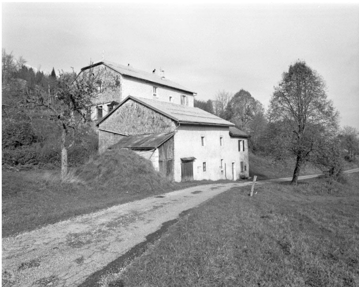
Façade postérieure et face droite.
