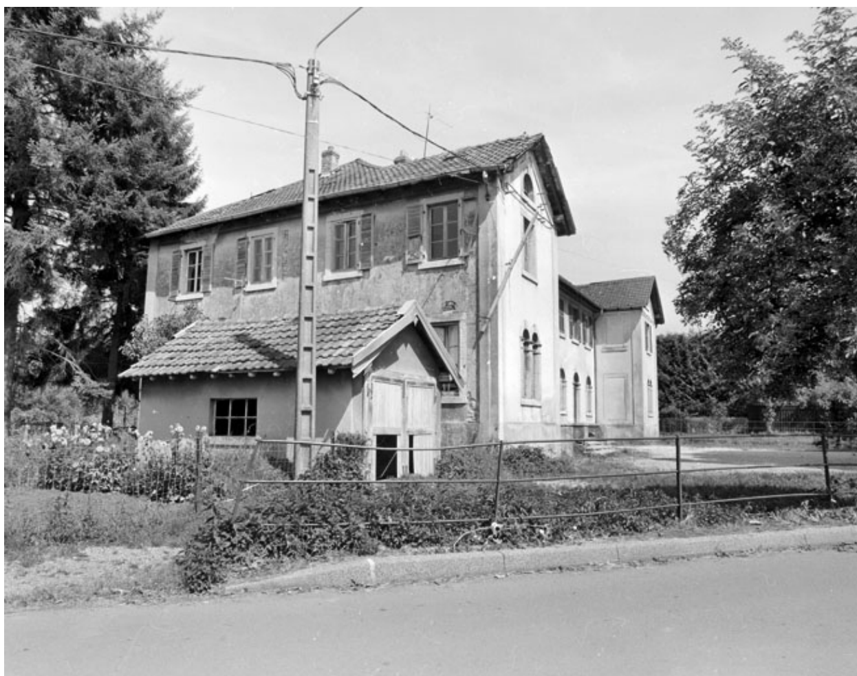
Elévation depuis l'ouest.
