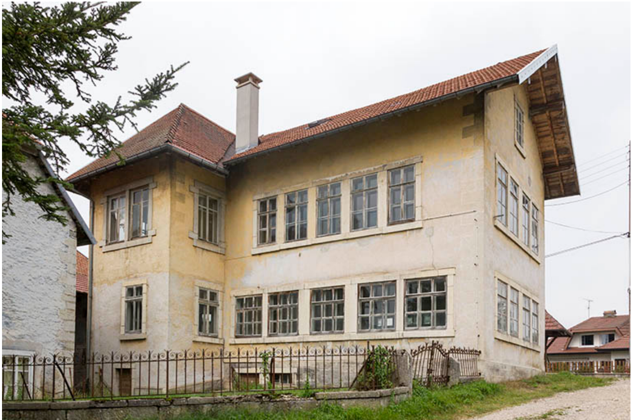
Usine : façades postérieure et latérale gauche.
