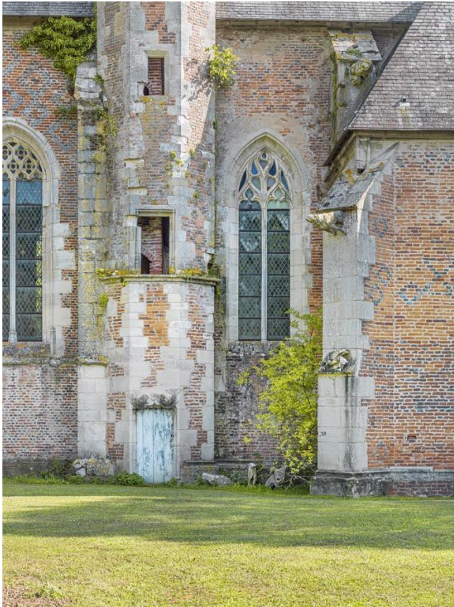
Porte de la tourelle d'escalier.
