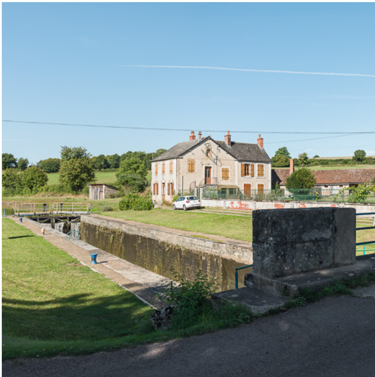
Vue du site d'écluse.
