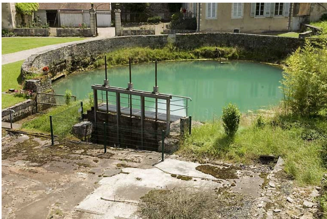
Le bassin de la source et le vannage.
