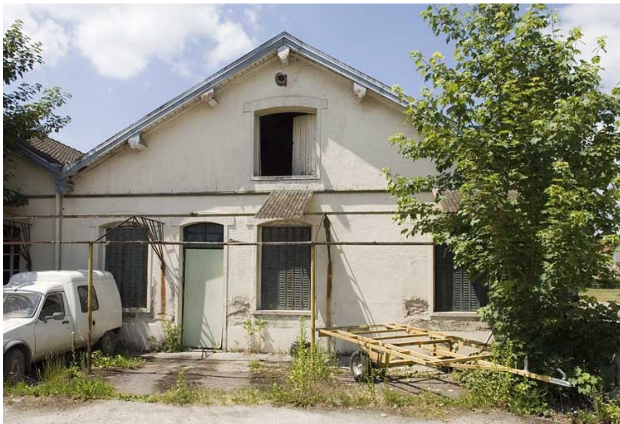
Bâtiment des bureaux (?).
