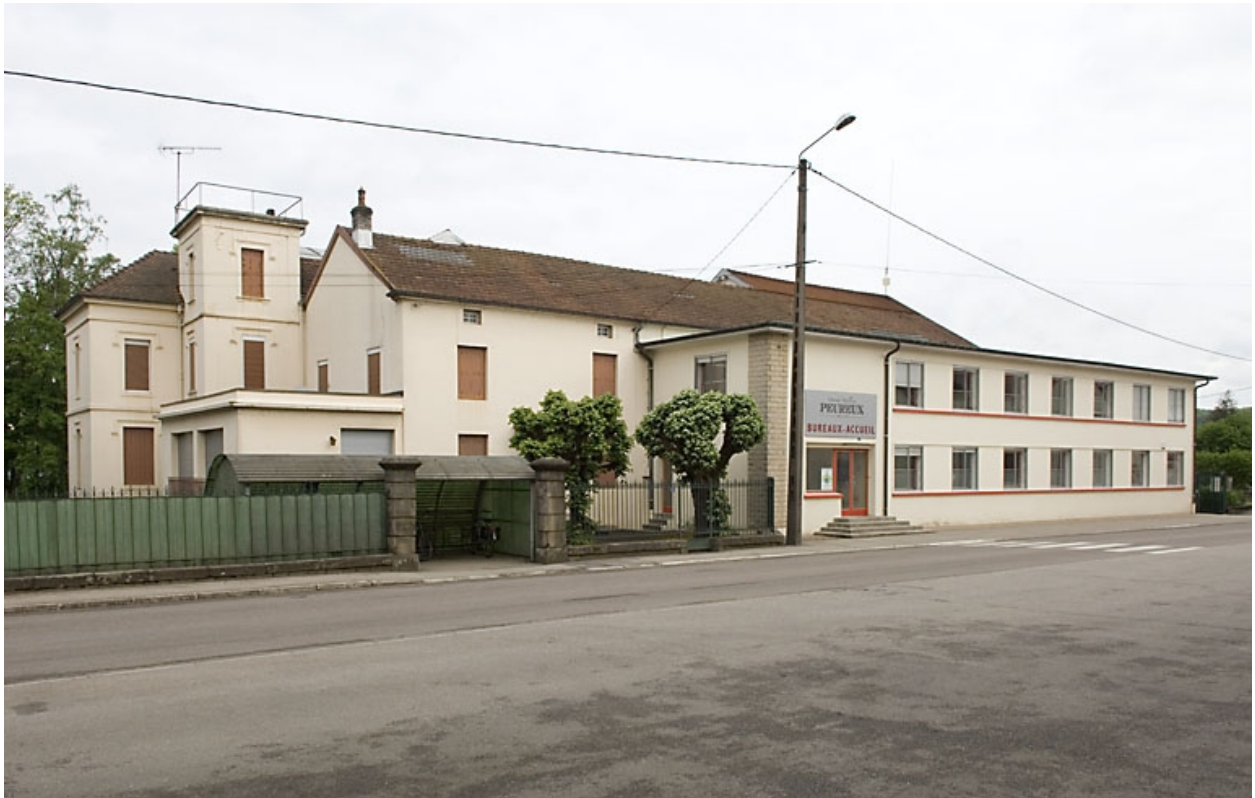
Ancien logement patronal et bureau.
