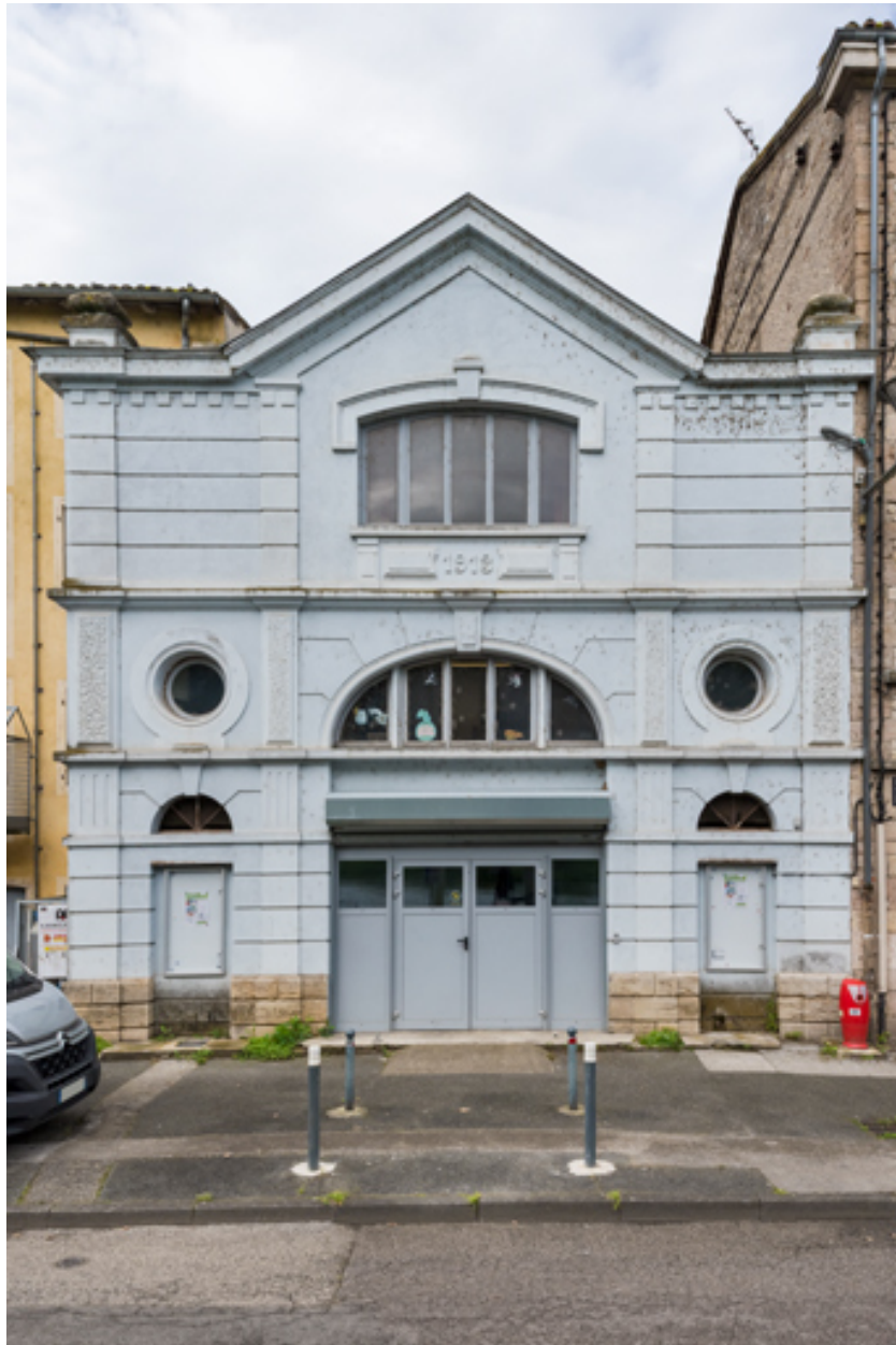
Façade postérieure, quai de Verdun.
