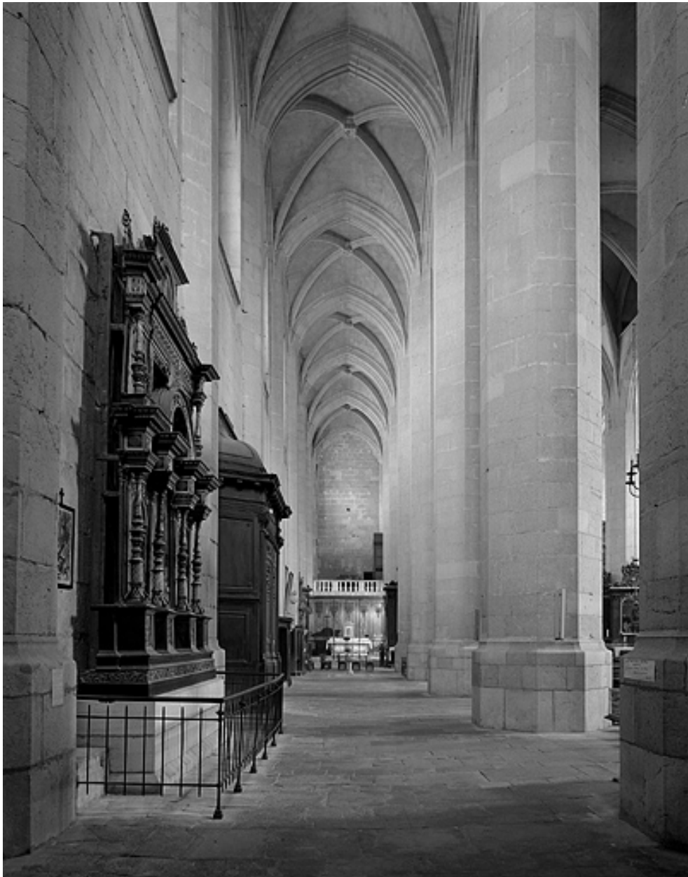
Vue du collatéral nord vers l'est.
