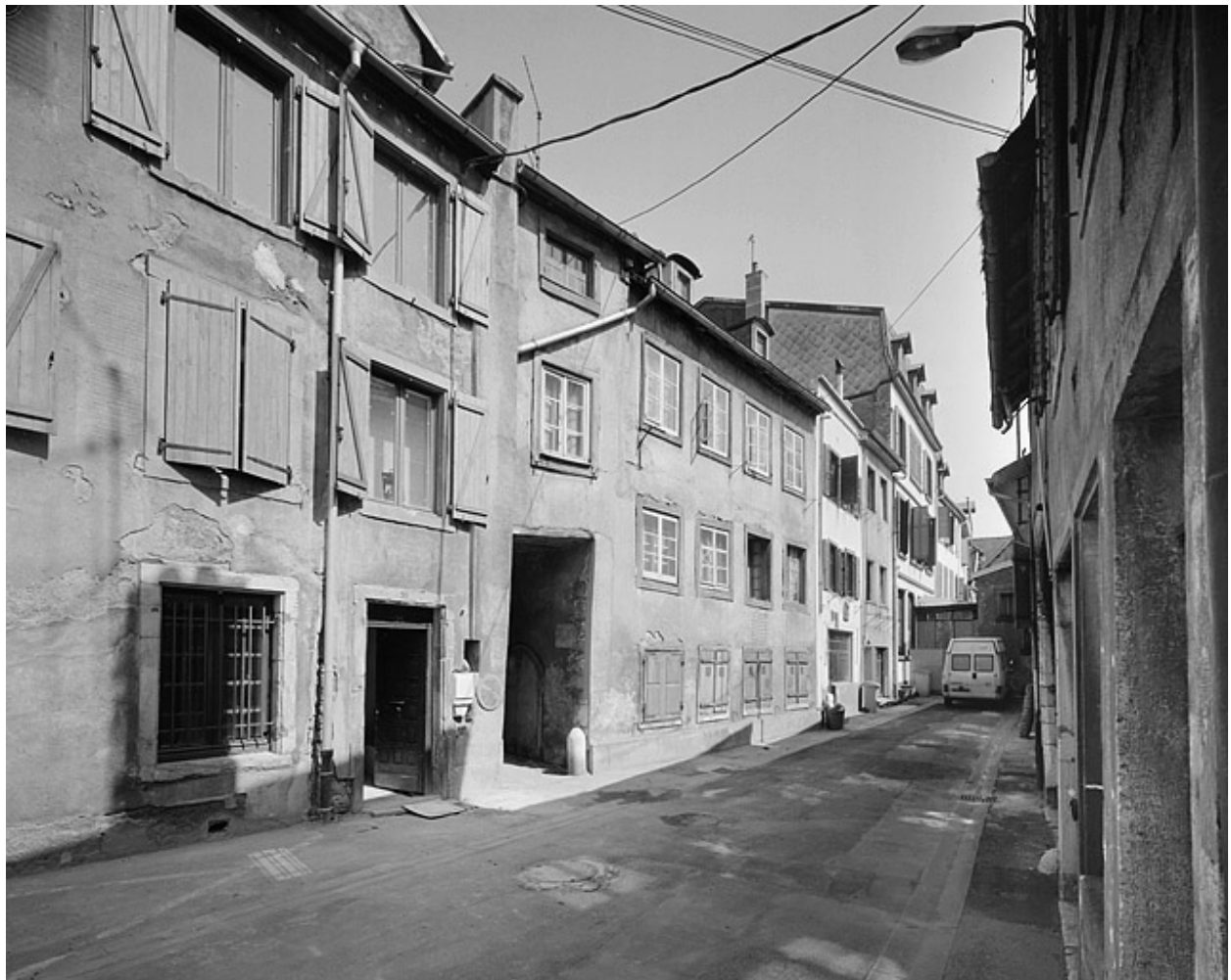
Façade sur l'impasse du Laquet.
