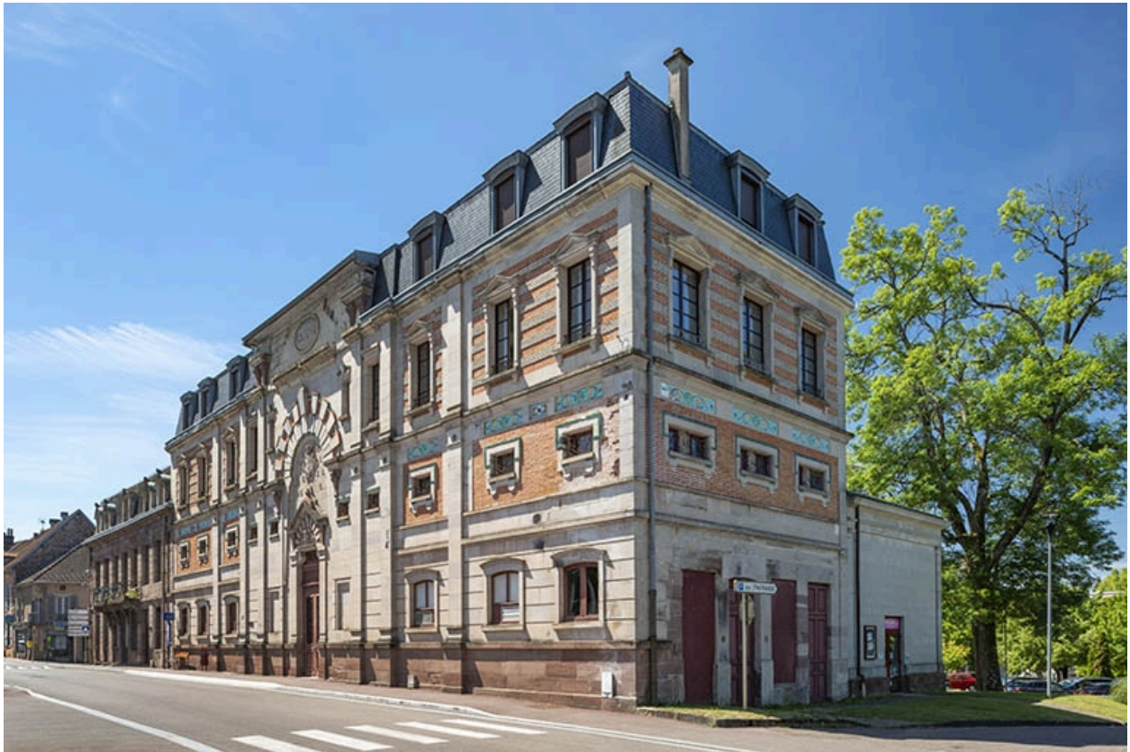
Façade sur la rue de Grammont, vue prise depuis le nord-est.
