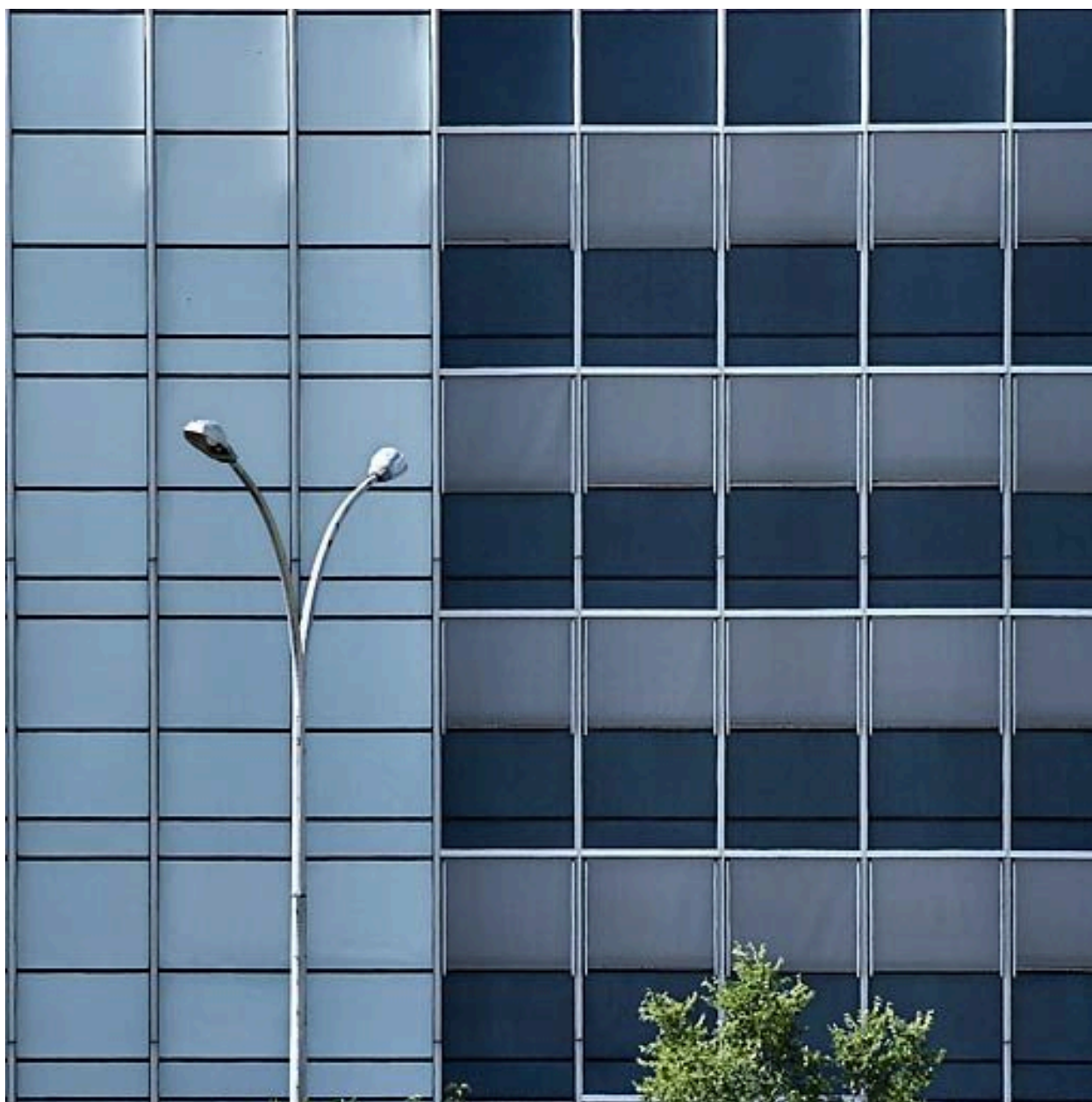
Bâtiment principal, détail.
