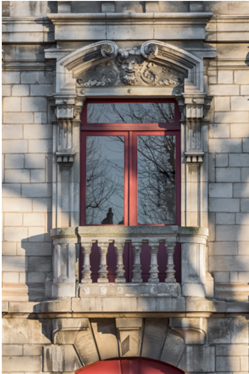
Façade latérale droite, étage carré : baie centrale.
