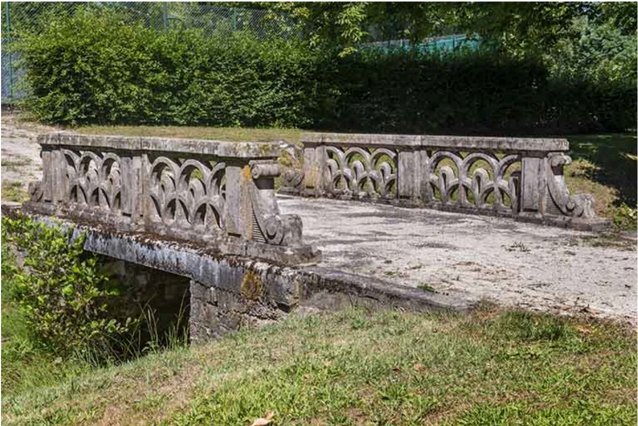
Pont à garde-corps en pierre.
