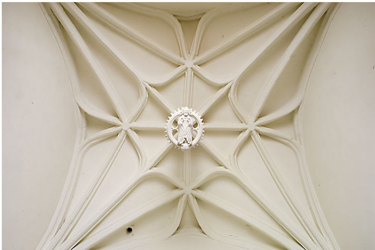
Voûte de la sacristie.
