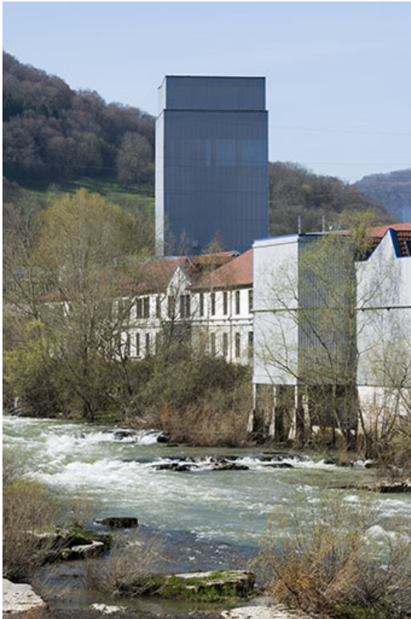
Ateliers de l'usine de laminage (rive gauche).
