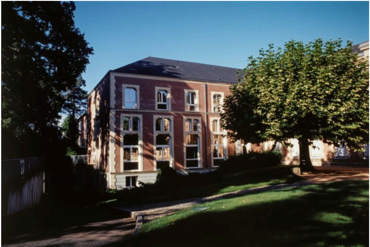
Façade postérieure, partie gauche.
