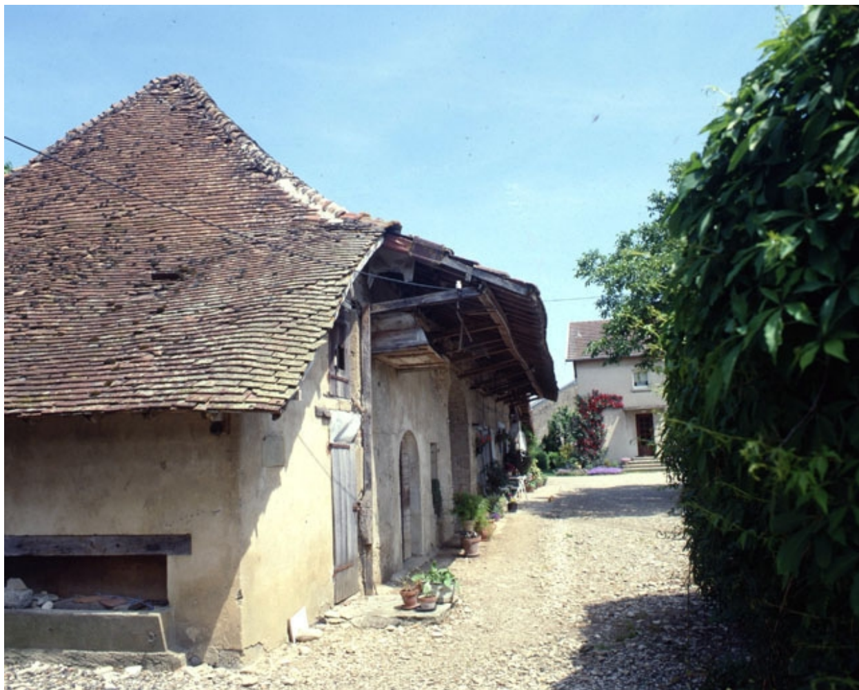
Façade antérieure en 1990 : vue de trois-quarts gauche.
