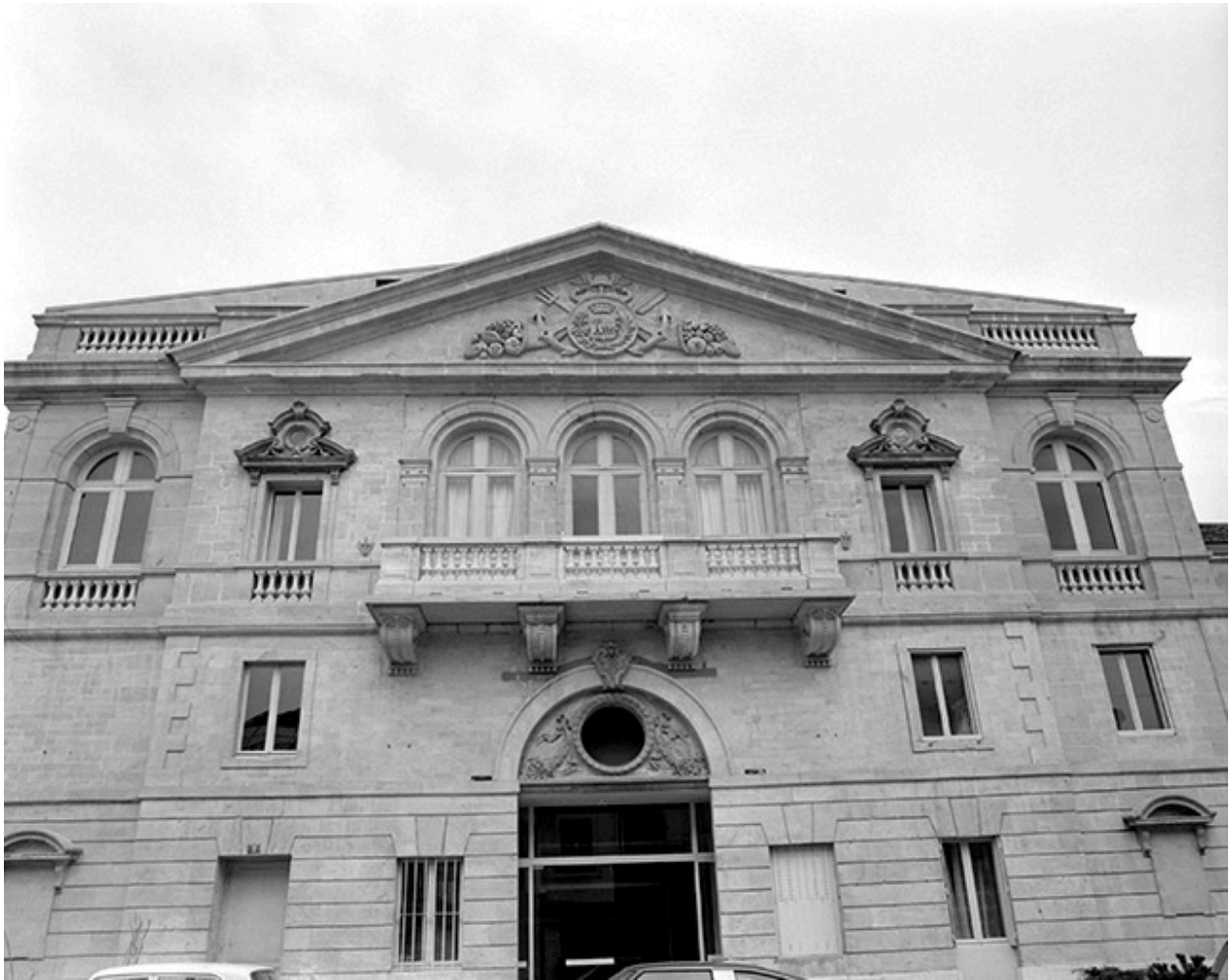
Façade antérieure. Corps central, vue d'ensemble.
