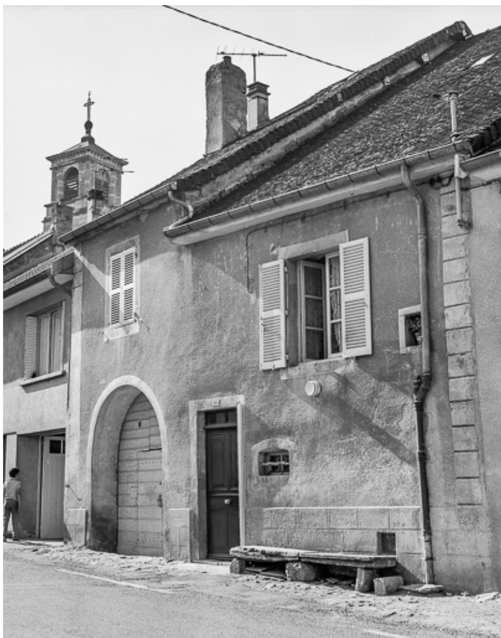
Ferme située à Perrigny.
