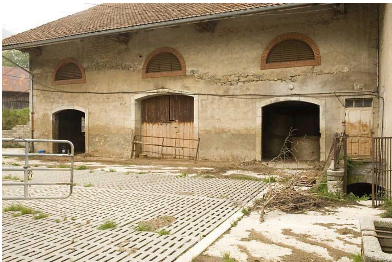
Etables et granges : façade latérale gauche.
