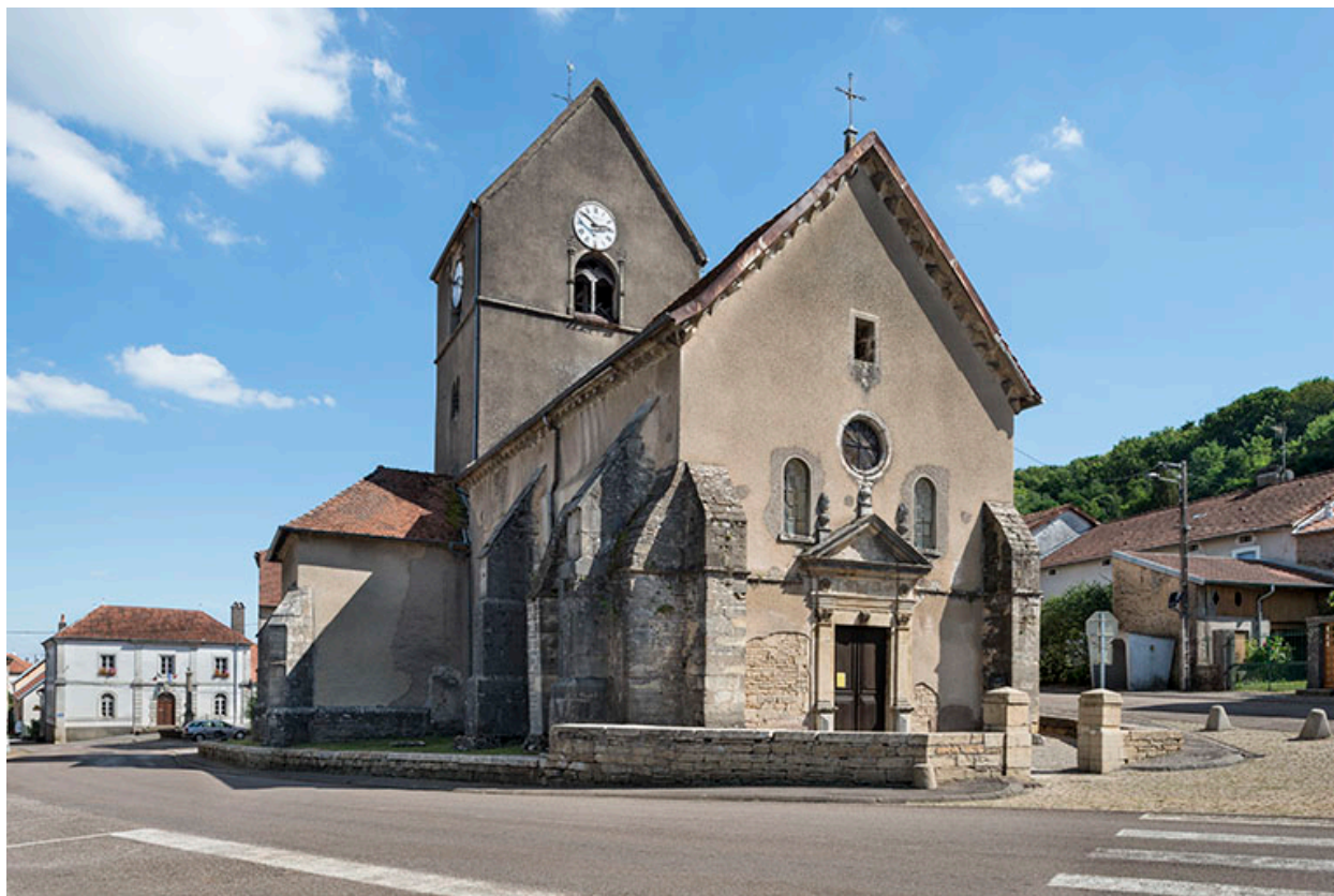
Vue avant restauration (2016).
