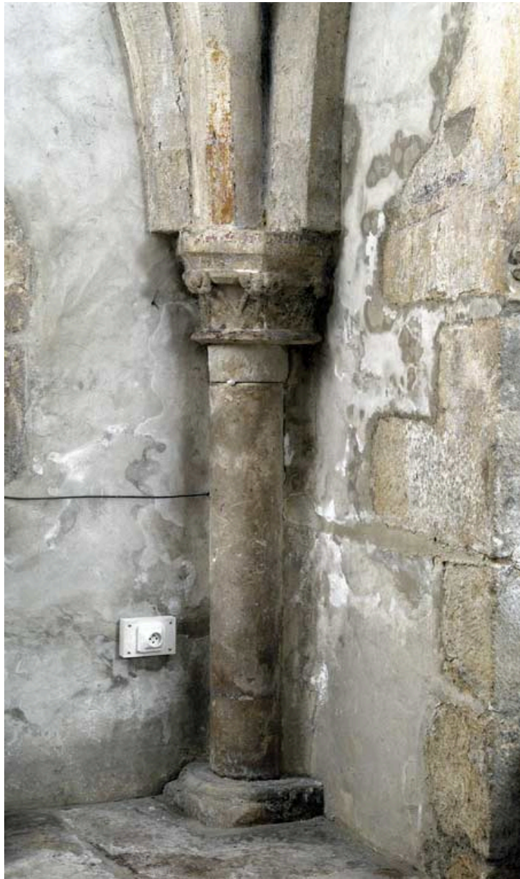
Chapelle dite des fondateurs : travée postérieure, colonne antérieure droite.
