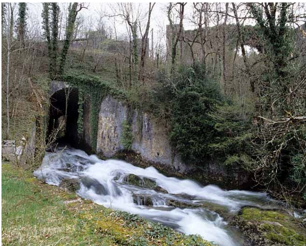
Pont sur le Lizon, depuis l'aval (sud). Pont du tacot à l'arrière-plan.
