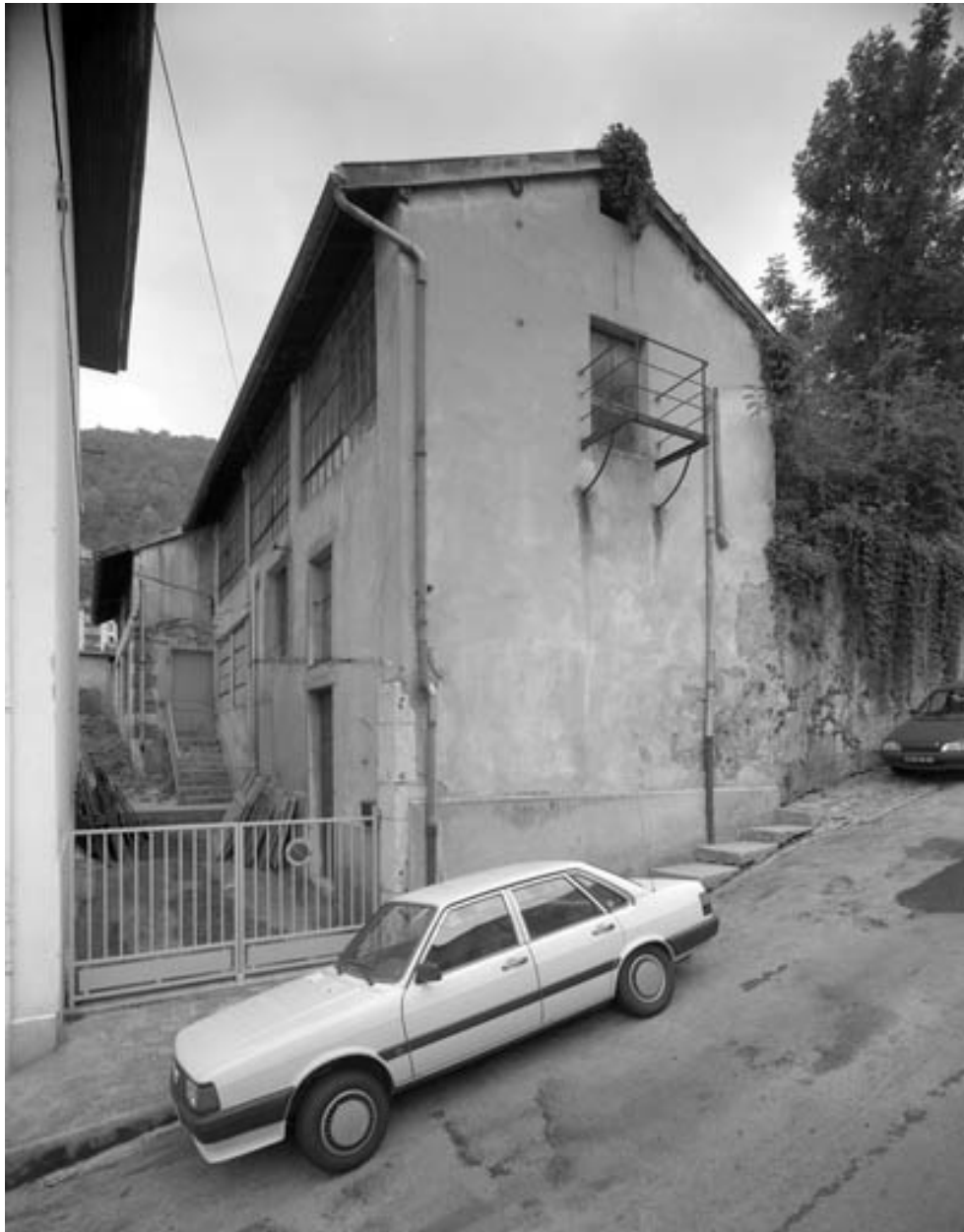
Entrepôts industriels (ancienne usine Genoud).
