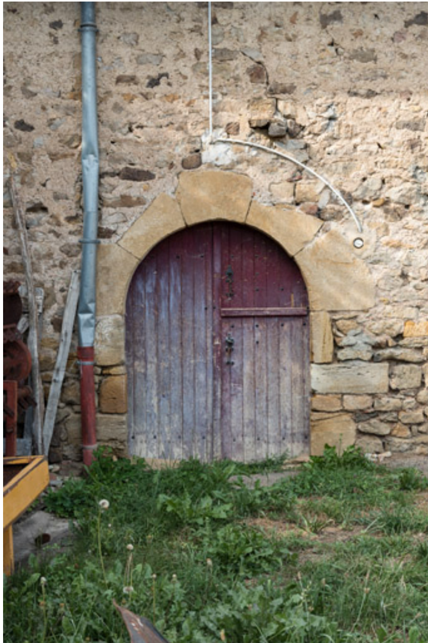
Porte de l'étable de la grange de la ferme n°4, couverte d'un arc en plein cintre.
