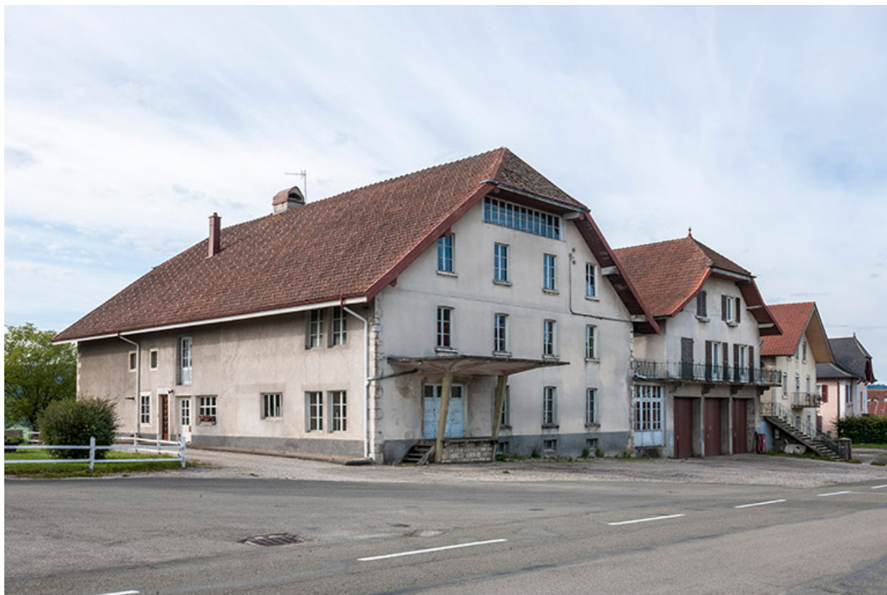
Vue de trois quarts depuis le nord.
