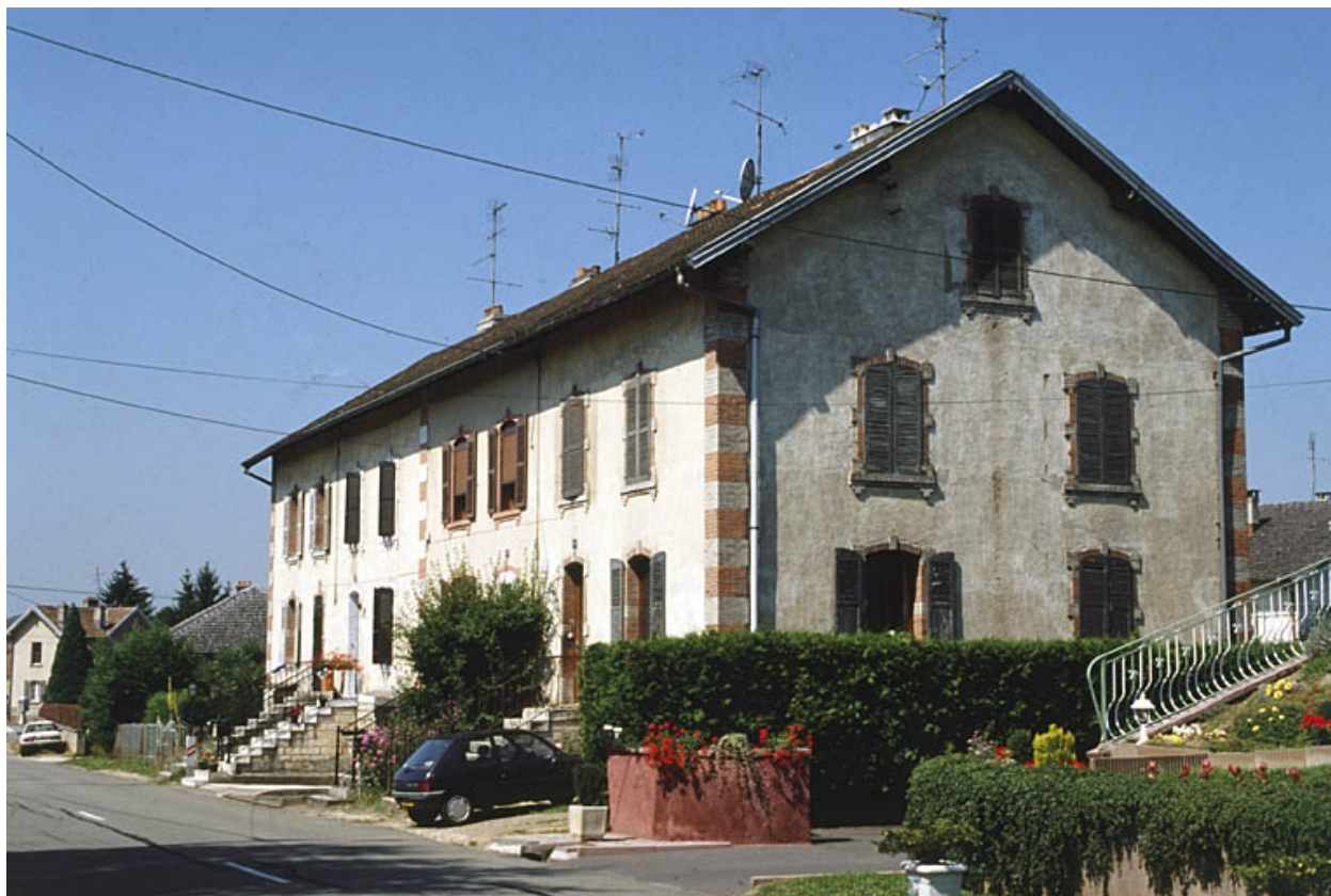
Maison à logements multiples route de Boron.
