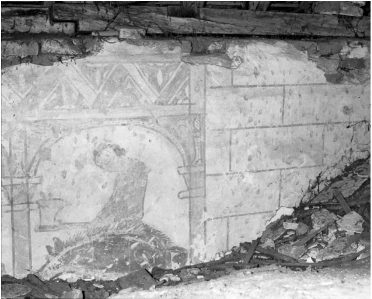
Comble de la nef, mur droit : décembre
