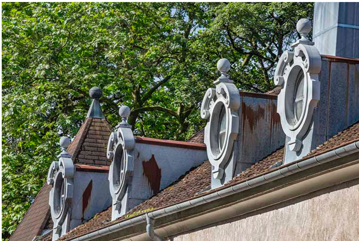
Maisons canoniales. Détail des lucarnes.
