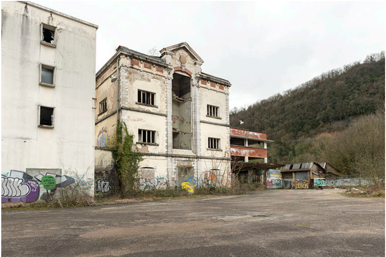
Etat en 2016. Usine A : façade antérieure de la cantine.
