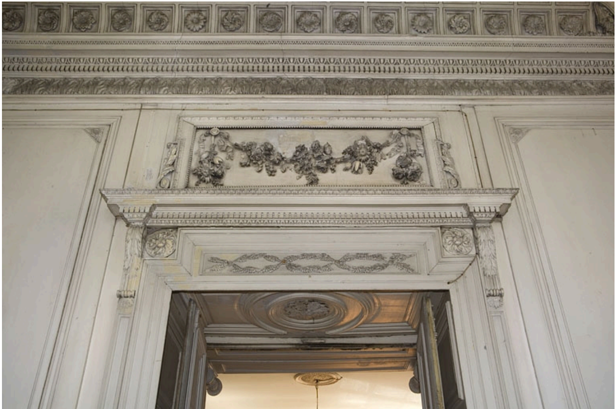
Hôtel en fond de cour, grand salon : détail du dessus de porte, côté antichambre.
