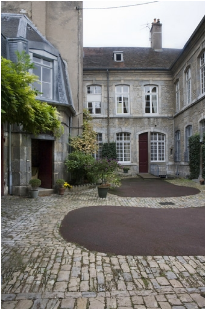
Vue d'ensemble des façades sur cour de l'hôtel.
