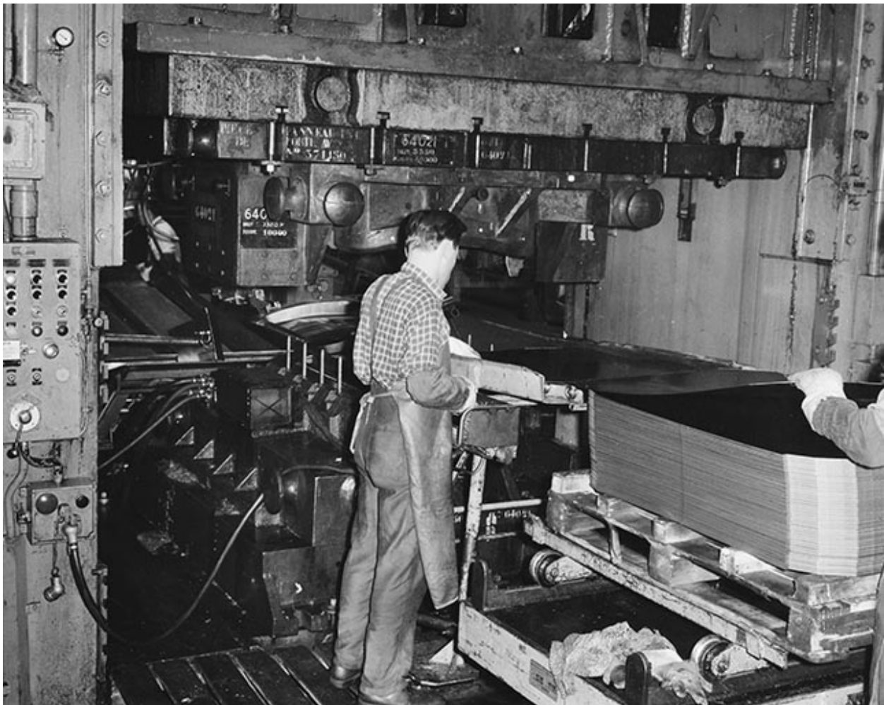
Atelier d'emboutissage. Presse hydraulique (2).
