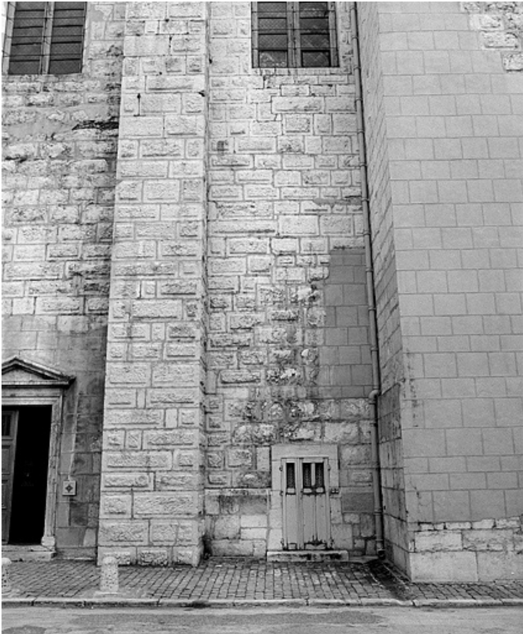
Détail du flanc sud : couture à hauteur de la sixième travée.
