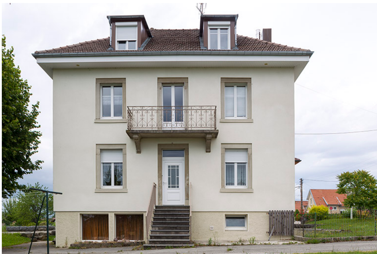
Logement patronal : façade latérale droite.
