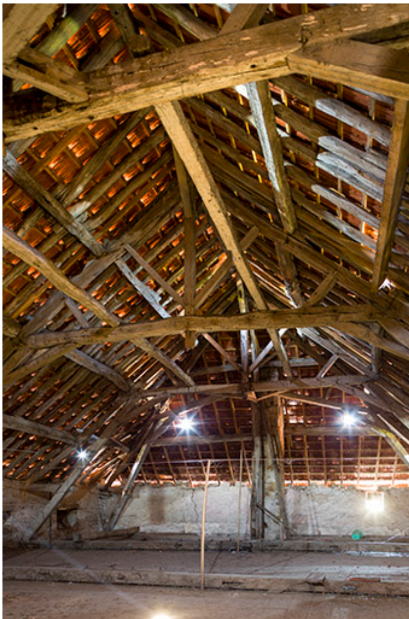
Vue intérieure de la charpente de toit.
