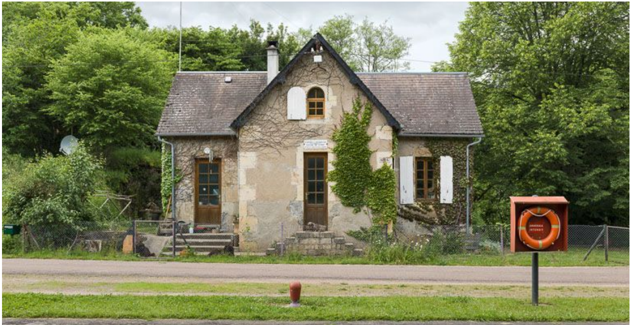
Vue de face de la maison éclusière.
