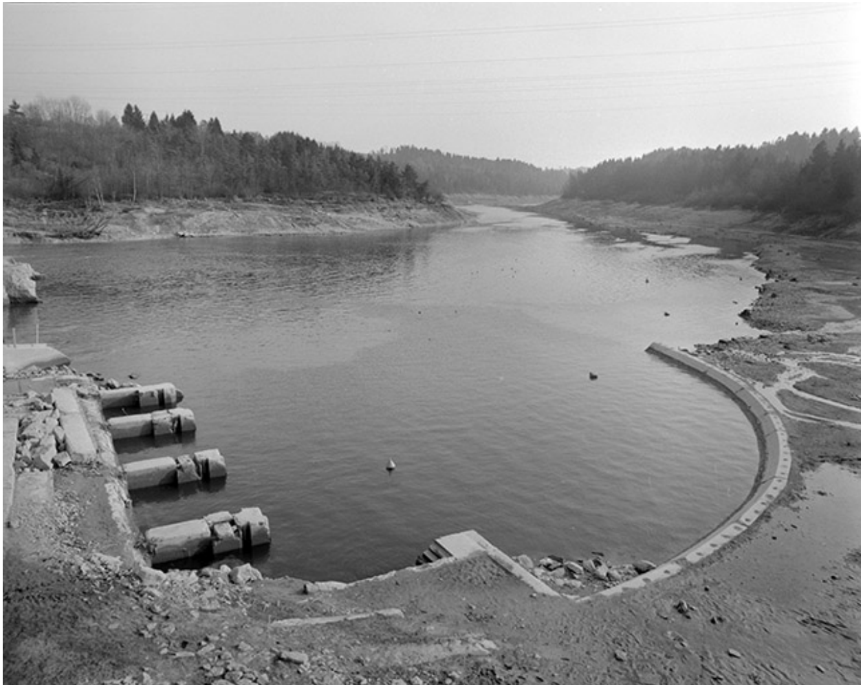
Fondations et bassin d'amortissement.
