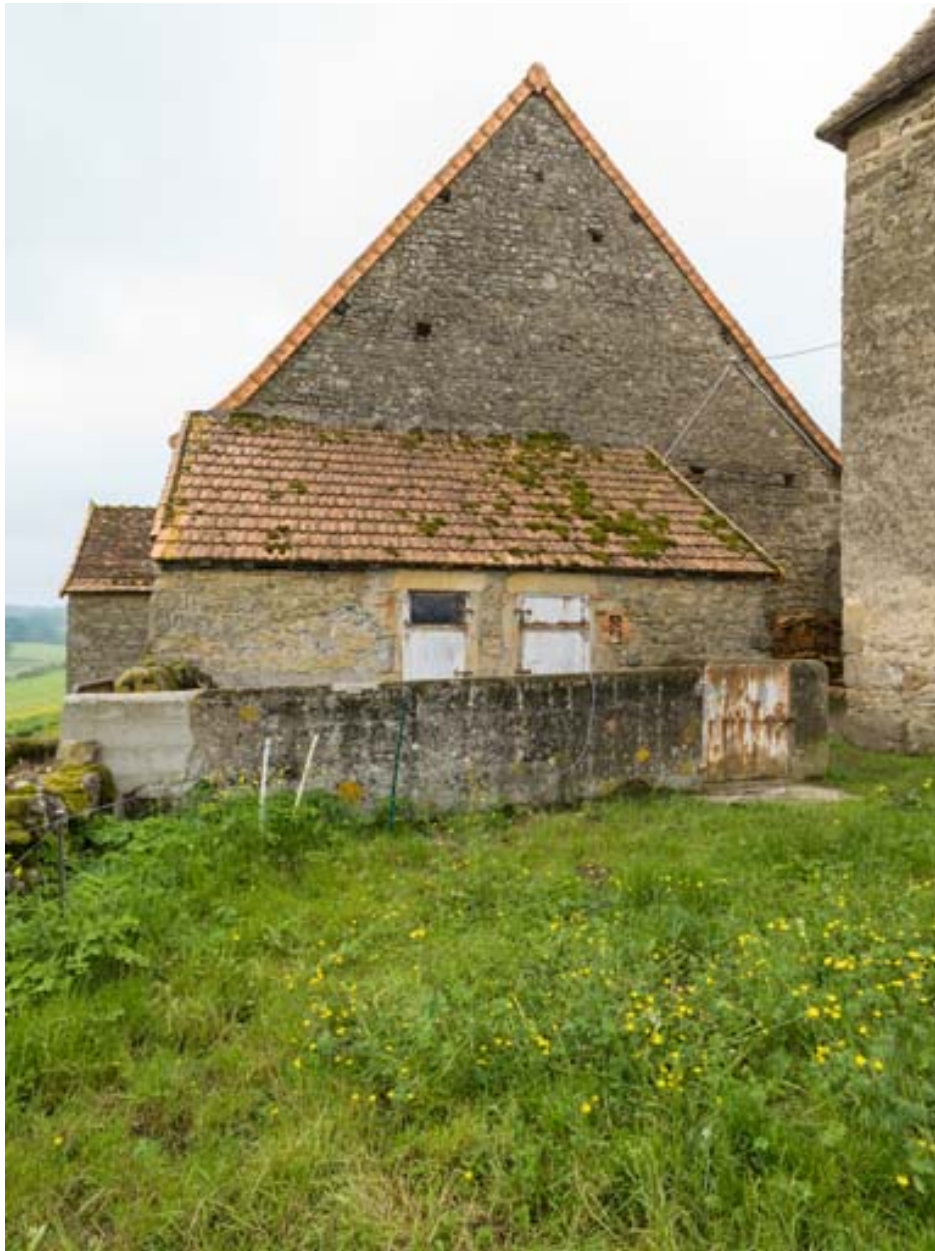
La soue adossée au pignon de l'étable.
