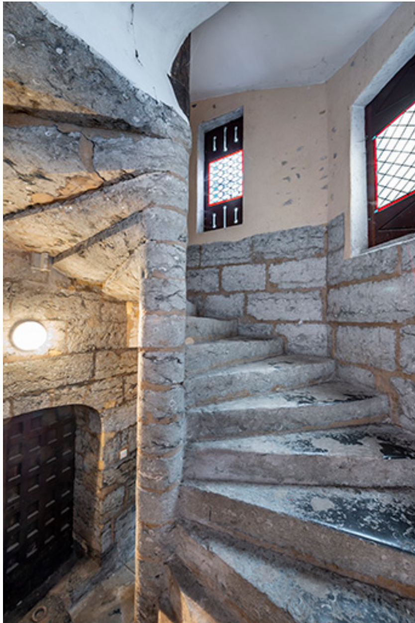
Escalier en vis : accès au premier étage.
