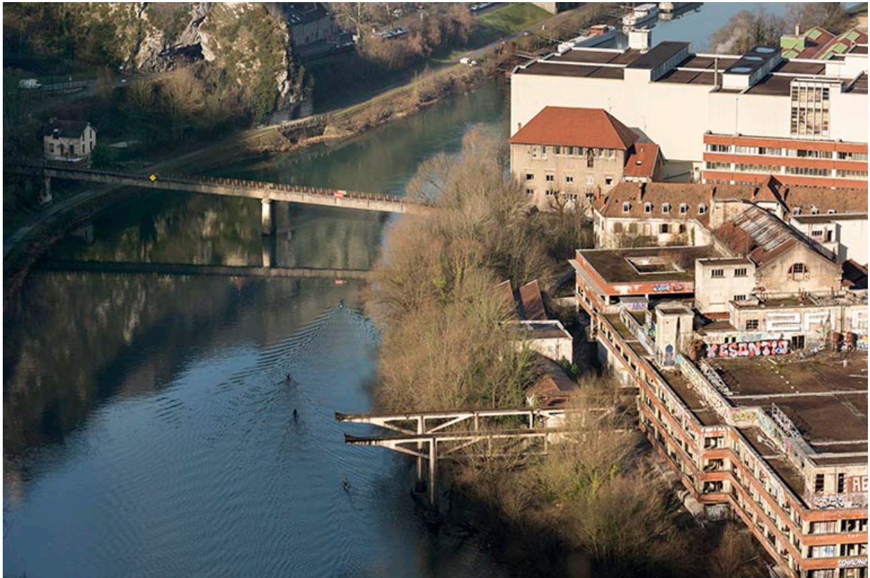
Etat en 2016. Usine A : portique en béton du pont roulant et passerelle sur le Doubs.
