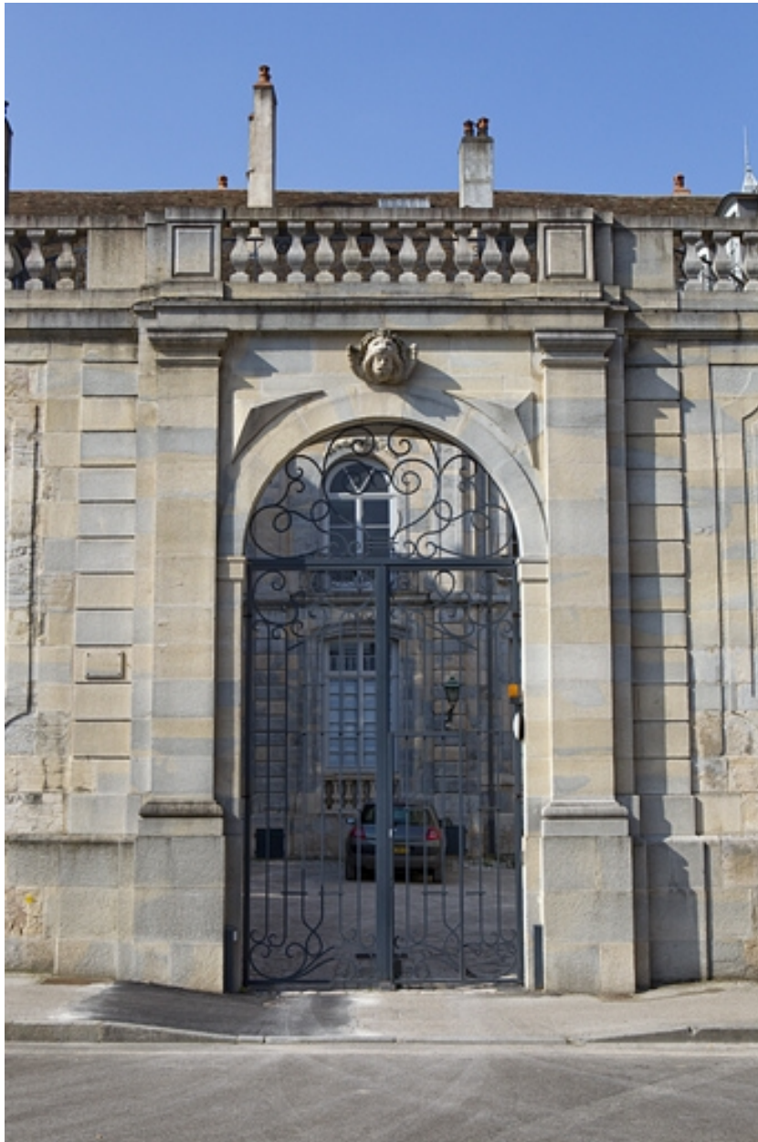
Vue d'ensemble du portail dans clôture.
