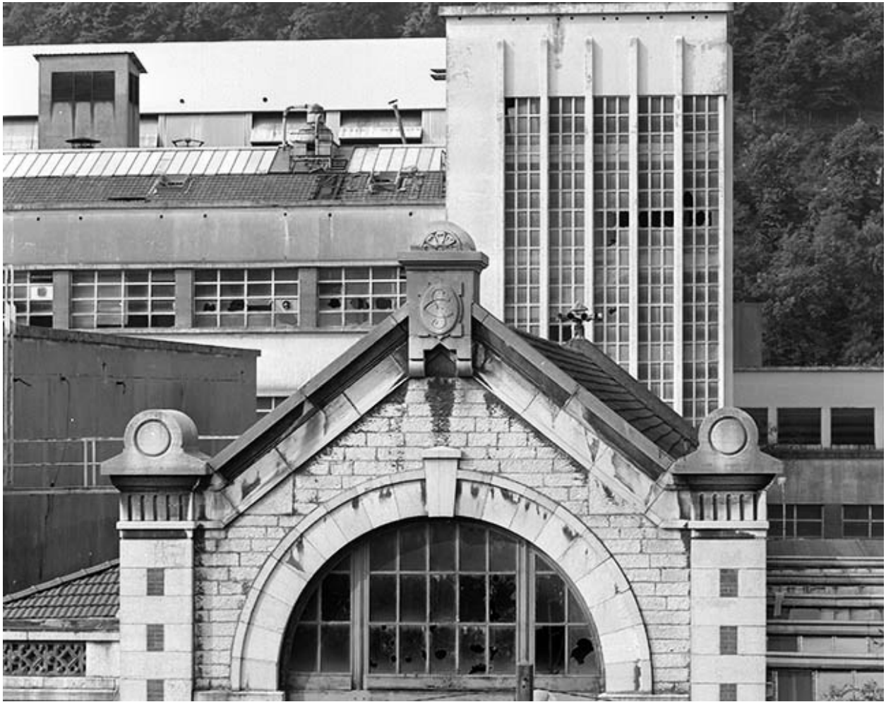
Fronton de la chaufferie.
