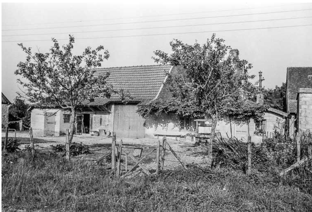
Ferme cadastrée 1956 A2 431 : façade antérieure.
